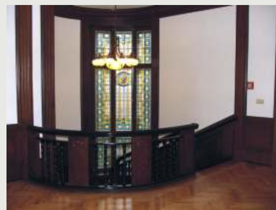
Restaurovaný historický dřevěný interiér – druhé podlaží
