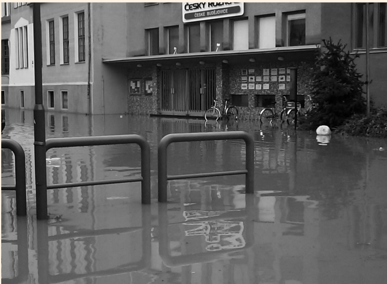
Budova ČRo České Budějovice při povodních 2002
