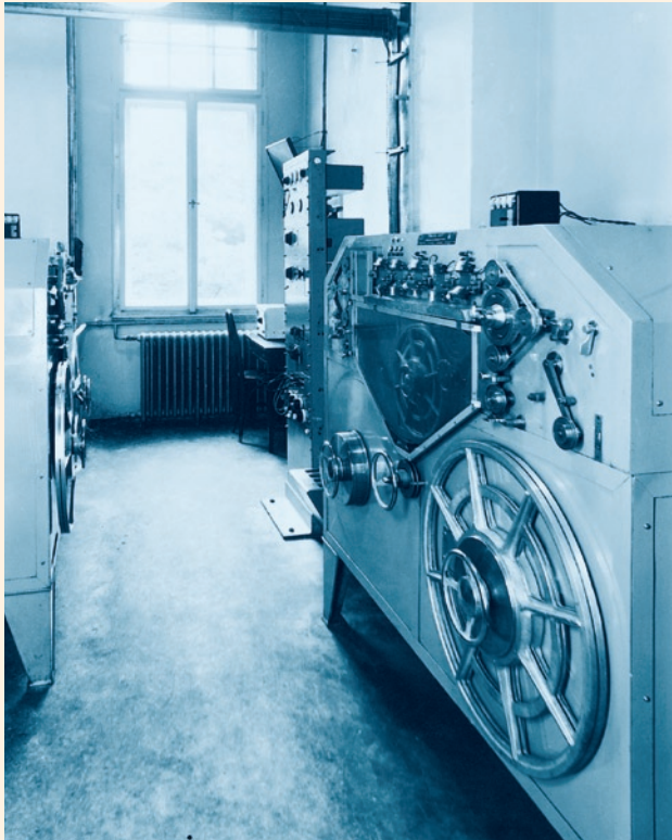
Blattnerphon, stroj pro záznam zvuku na ocelový pás (1939)
